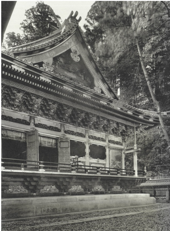
図 1 日光東照宮本殿東面
